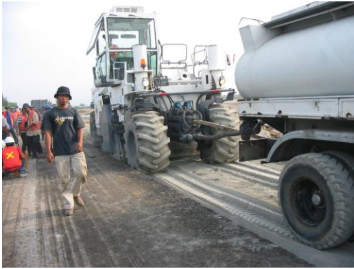
Gambar 3. Proses pencampuran semen dengan alat pencampur (recycler).
